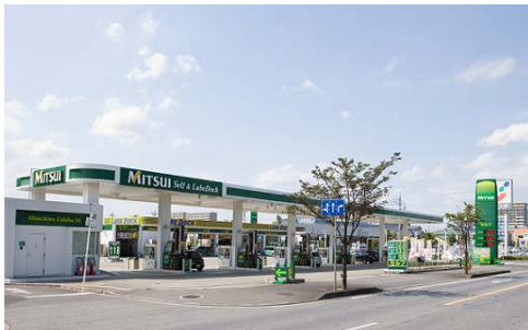
写真①外部照明省電力システムの実証実験が行われている ひたち野うしくセルフサービスステーション
