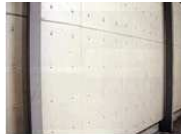
【騒音対策：防音吸音材の使用】
