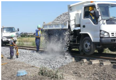
昨年 9 月に発生した関東・東北 豪雨による災害復旧現場
