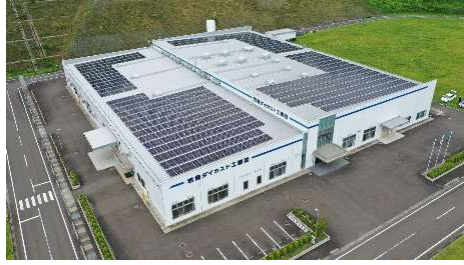
自然エネルギーの活用 太陽光発電パネルの設置
