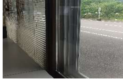
外気温の影響を軽減 断熱対策（二重窓施工）
