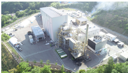
西風新都バイオマス発電所
