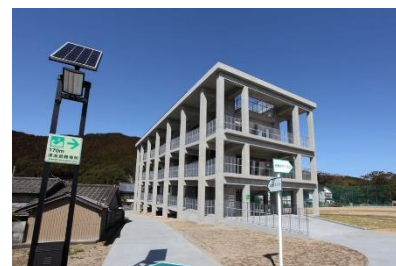
南海トラフ地震に備えた津 波避難タワーの新設 (徳島県)
