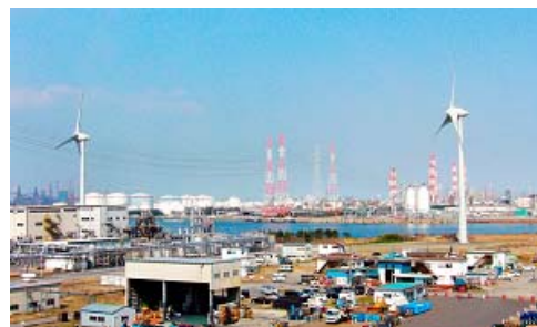
風力発電設備*の全景
