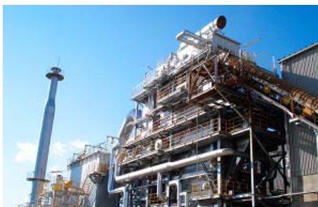
バイオマス発電設備*の外観
