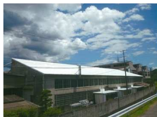
工場内部の温度上昇を 抑え、省エネに寄与する 屋根遮熱塗装の採用
