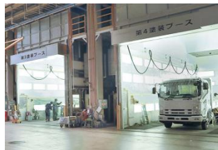
環境と品質に配慮した最新鋭 の塗装ブース
