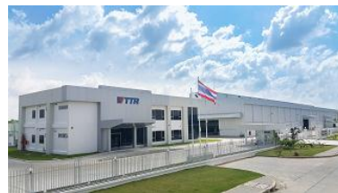
平成 27 年 10 月より稼働したグループ 4 番目の海外生産拠点となるタイ工場
