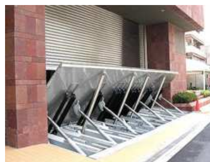
防潮板の設置
