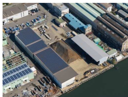
太陽光発電システムを備えた 川崎事業所
