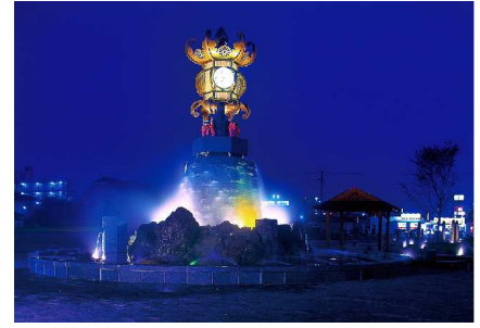
噴水設置工事
