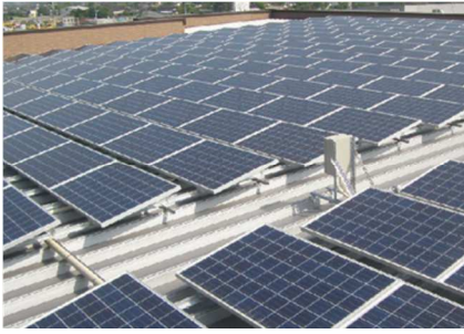
太陽光発電施設工事
