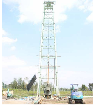
温泉掘削・さく井工事
