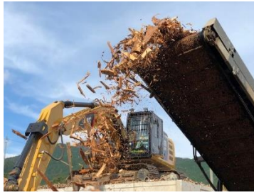
木くず処理プラント
