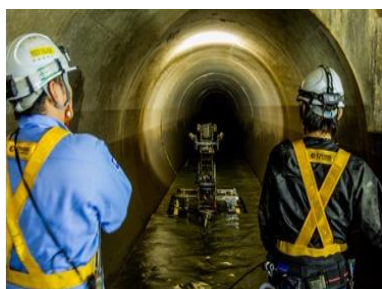
ロボットを駆使した 下水道管理
