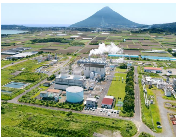
山川発電所（鹿児島県）総出力 30MW
