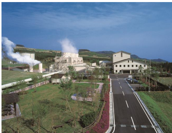
大霧発電所（鹿児島県）総出力 30MW
